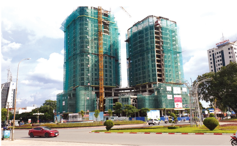
Dự án Tòa tháp đôi Prime Thái Nguyên do Công ty Prime Thái Nguyên xây dựng trên diện tích 60.000m², tổng kinh phí gần 700 tỷ đồng dự kiến hoàn thành và đưa vào sử dụng vào tháng 4-2023.
