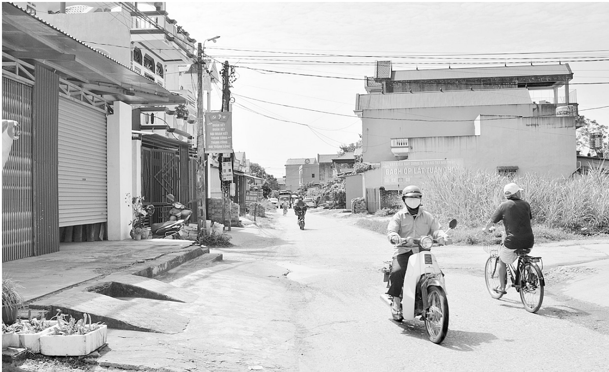
Tuyến đường từ trung tâm xã Tân Đức đi các xóm: Ngoài, Viên, Tân Thịnh và Quần có chiều dài 1,8km đã được giải phóng mặt bằng, chuẩn bị đổ bê tông toàn tuyến vào tháng 12 tới.
