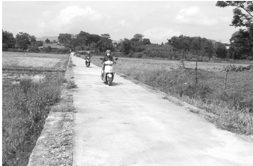
Cơ bản các tuyến đường ở xóm Chằm, xã Động Đạt đã được đổ bê tông, với sự đóng góp của người dân trong hiến đất và tiền đối ứng.
