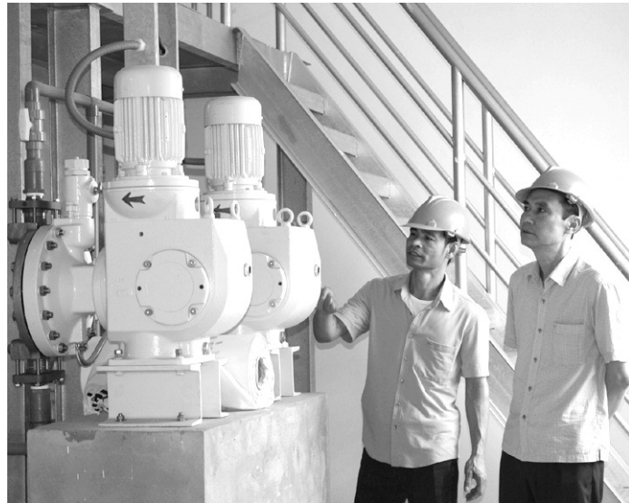
Để nâng cao năng lực và hiệu quả sản xuất - kinh doanh, năm 2023, Công ty CP nước sạch Thái Nguyên sẽ đưa vào vận hành Nhà máy nước Nam Núi Cốc với công suất 50.000m³/ngày đêm... Trong ảnh: Lãnh đạo Công ty CP nước sạch Thái Nguyên kiểm tra tiến độ thi công dự án Nhà máy nước Nam Núi Cốc.
