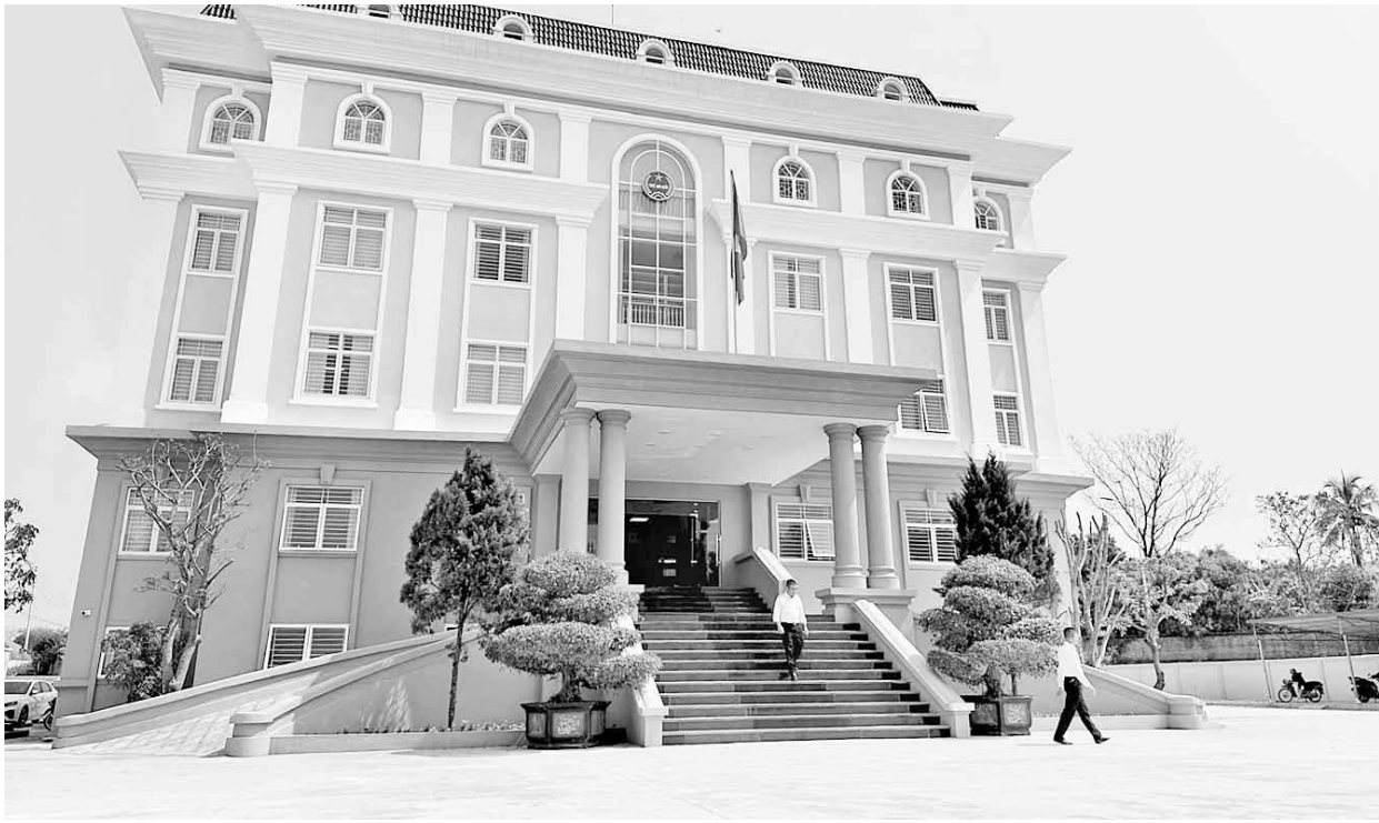
Công trình Trụ sở làm việc Chi cục Thuế khu vực Đồng Hỷ - Võ Nhai có tổng vốn đầu tư hơn 28 tỷ đồng đã hoàn thành đưa vào sử dụng từ quý I-2023, nhưng hiện nay phải đi vào bằng đường tạm.
