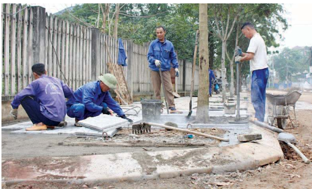
Thi công cải tạo, nâng cấp tuyến đường nội thị thuộc phường Thắng Lợi với chiều dài hơn 1km.
