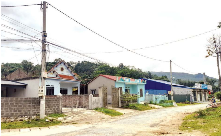
Nhiều nhà ở khu tái định cư xã Linh Thông được xây dựng khang trang nhưng lại không đúng với bản đồ quy hoạch chi tiết sử dụng đất và bản đồ địa chính (chính lý).
