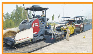
Thi công rải thảm bê tông nhựa Gối thầu TN-W-05B xây dựng đường Hoàng Thượng - Chua Hang - Phần đoạn 2 thuộc Dự án Phát triển tổng hợp đô thị động lực, TP. Thái Nguyên.
