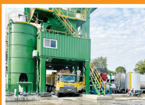
Dây chuyền thảm bê tông Asphalt công suất 120 tấn/h nhập khẩu đồng bộ từ Hàn Quốc đặt tại Cụm công nghiệp Cao Ngạn (TP. Thái Nguyên).
