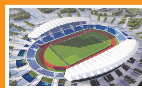
Thi công công trình Sân vận động Thái Nguyên.
