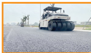
Thi công rải thảm bê tông nhựa Gối thầu TN-W-07 nâng cấp đường Lê Hữu Trác thuộc Dự án phát triển tổng hợp đô thị động lực, TP. Thái Nguyên.
