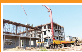
Thi công các công trình xây dựng công nghiệp và dân dụng.
