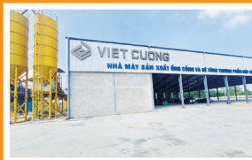
Nhà máy sản xuất bê tông thương phẩm công suất 120m 3 /h, ống cống và gạch ngói tại xã Phú Xuyên (Đài Từ).
