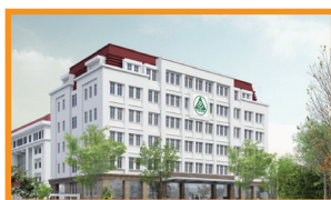
Thi công xây dựng công trình Nhà làm việc và bộ phận tiếp nhận, trả kết quả - Trụ sở HĐND và UBND TP. Thái Nguyên.
