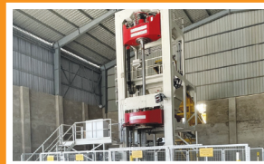
Dây chuyền sản xuất ống cống của hãng PRINZING PFEIFFER, công suất 500km cống/năm.
