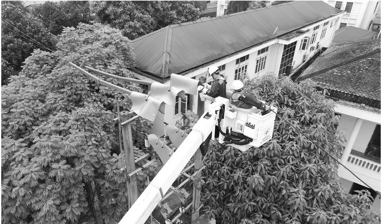
Từ nhiều năm nay, công nghệ sửa chữa hotline trên lưới điện được PC Thái Nguyên ứng dụng nhằm nâng cao chất lượng phục vụ khách hàng, mang lại hiệu quả thiết thực.
