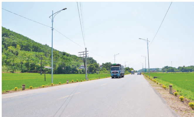
Hệ thống điện chiếu sáng, đoạn qua thị trấn Đu (Phú Lương) đã cơ bản được đón vị thi công hoàn thiện.
