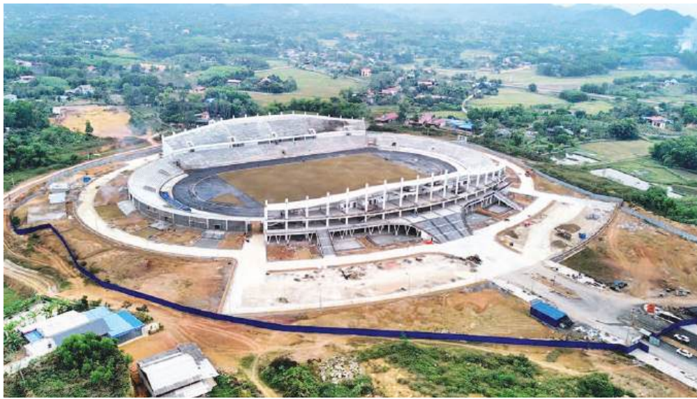
Sân vận động Thái Nguyên đang được hoàn thiện.
