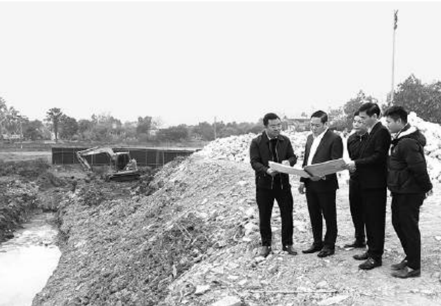
Lãnh đạo UBND huyện Phú Lương kiểm tra tiến độ thi công các hạng mục công trình.
