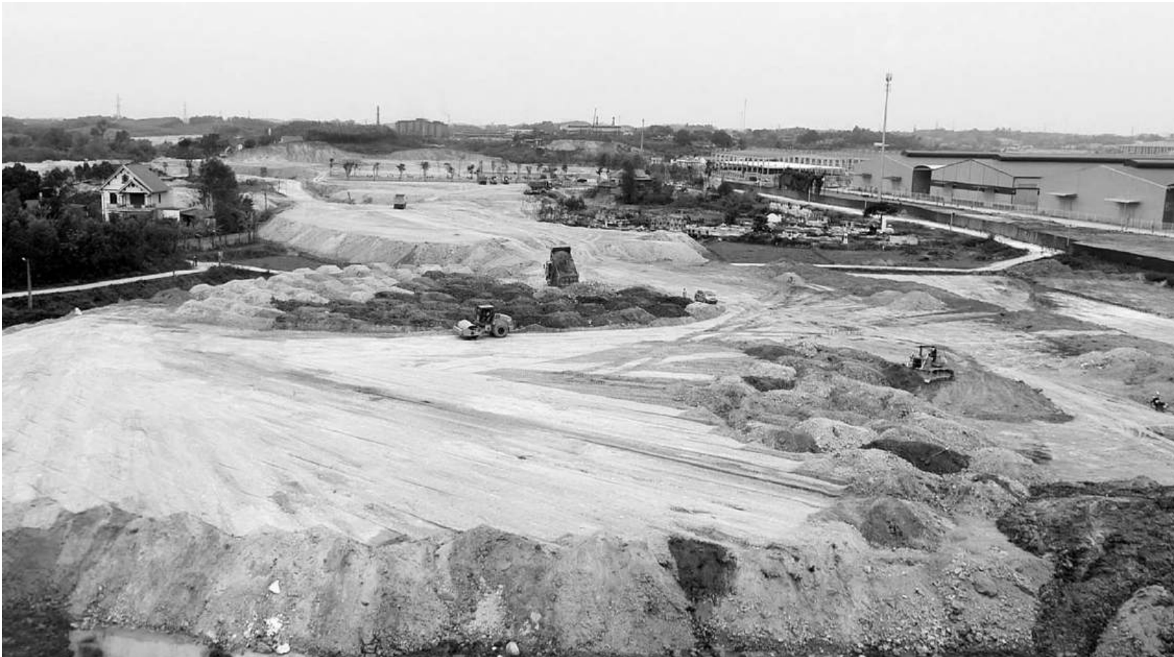
Công tác giải phóng mặt bằng thực hiện Dự án đầu tư xây dựng và kinh doanh kết cấu hạ tầng Khu công nghiệp Sông Công II - giai đoạn 2 đang được đẩy nhanh tiến độ triển khai. Ảnh: P.T
