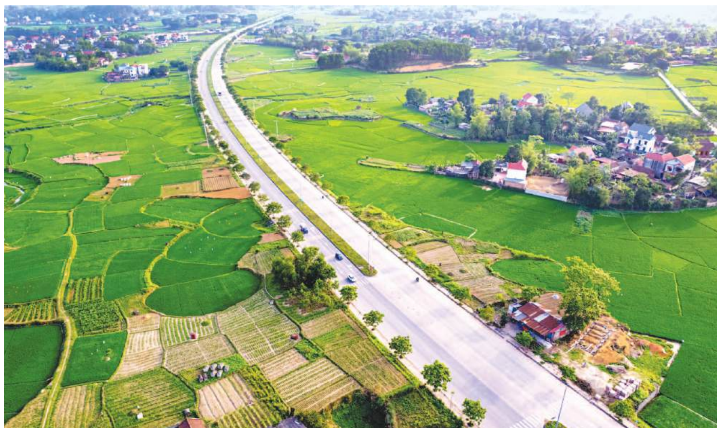
Tuyến đường Vành đai V vùng Thủ đô Hà Nội - đoạn tuyến qua TP. Phổ Yên và huyện Phú Bình, tạo thêm không gian phát triển tại khu vực phía Nam tỉnh Thái Nguyên.
