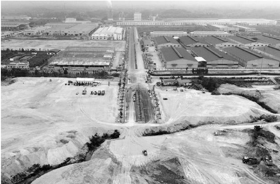
Triển khai gói thầu số 2 thuộc Dự án đầu tư xây dựng và kinh doanh kết cấu hạ tầng Khu công nghiệp Sông Công II - giai đoạn 2. Ảnh: M.H
