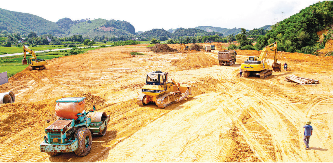
Cụm công nghiệp Yên Lạc có quy mô 25,6ha, nằm sát tuyến cao tốc Thái Nguyên - Chợ Mới, đang được đẩy nhanh tiến độ xây dựng hạ tầng.
