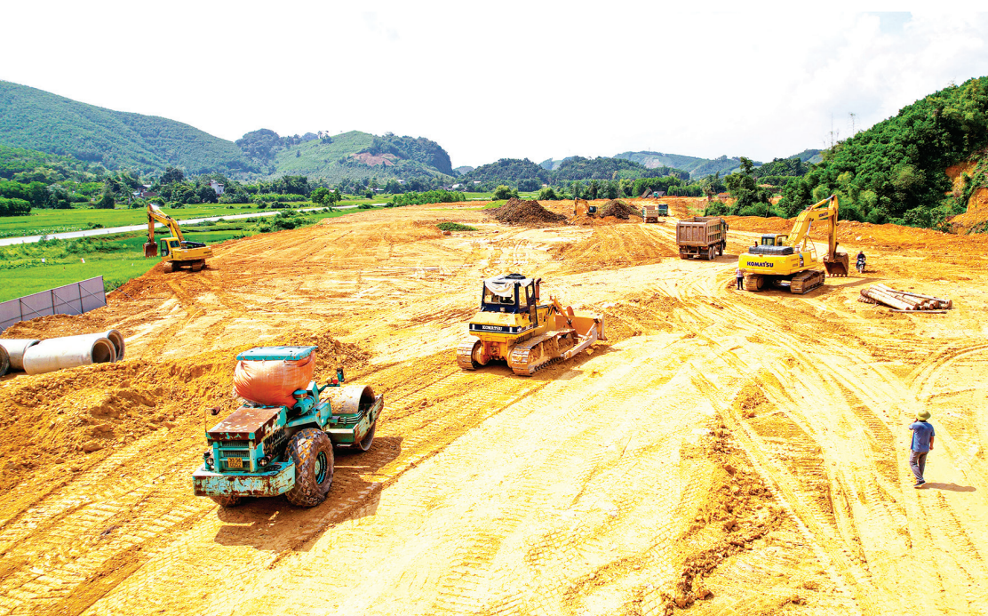
Cụm công nghiệp Yên Lạc (xã Phú Lương) có quy mô 25,6ha, nằm sát tuyến cao tốc Thái Nguyên - Chợ Mới, đang được đẩy nhanh tiến độ thực hiện.
