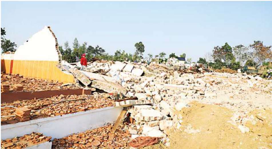
Các hộ dân trong vùng dự án chủ động phối hợp tháo dỡ công trình, bàn giao mặt bằng theo đúng kế hoạch.
