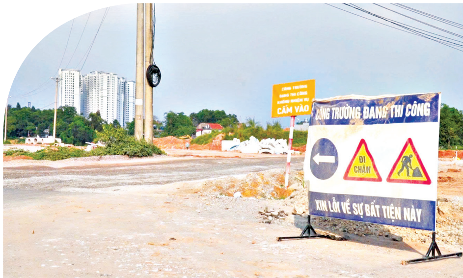
Không thể đóng đường cấm người dân đi lại, đơn vị thi công đường Bắc Sơn kéo dài cũng lắp đặt đầy đủ biển chỉ dẫn để người di chuyển chú ý quan
